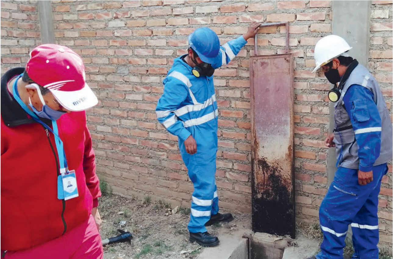
Trabajadores realizando su labor cotidiana en la planta de tratamiento de aguas residuales en Villazón.
